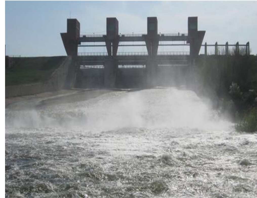
Гилёвское водохранилище (пропускная дамба), Алтайский край
