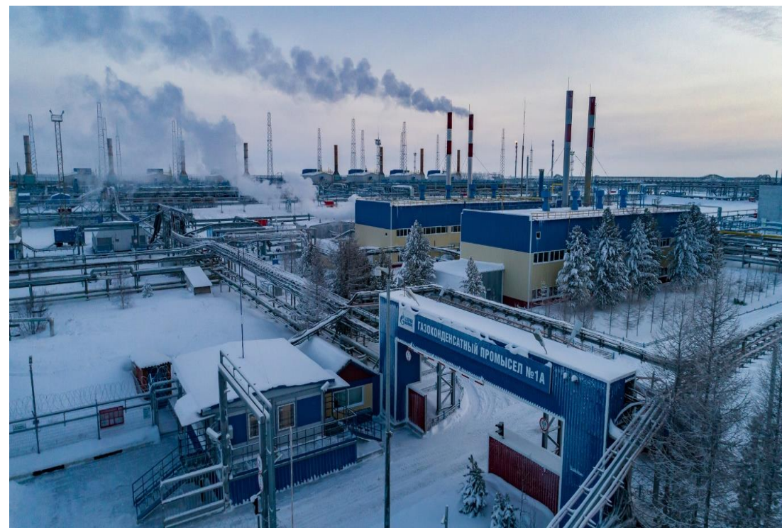
Газоконденсатный промысел №1А Уренгойского газопромыслового управления ООО «Газпром добыча Уренгой»
