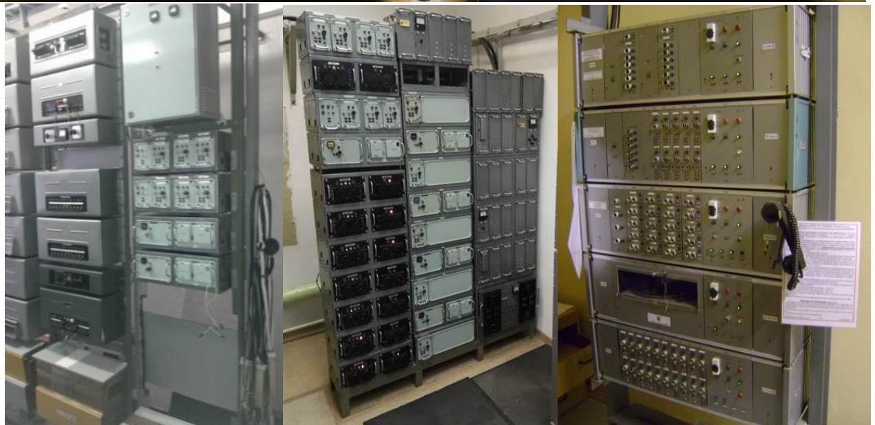
Аппаратура оповещения П-160, П-164, П-157 и АДУ-ЦВ.
